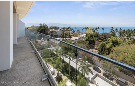
MIS Valparaíso Nueva Construcción
